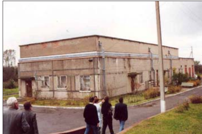
Gebäude, in dem das neue Pflegebad entstehen soll.
